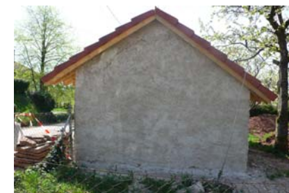
Lavoir après l'ajout de l'enduit à la chaux sur les murs
