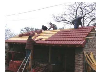
Pendant les travaux
