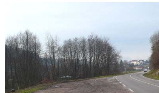
Vue sur la vallée du Rabodeau avant travaux
