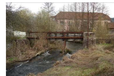
Vestige d'ouvrage à la Petite Raon
